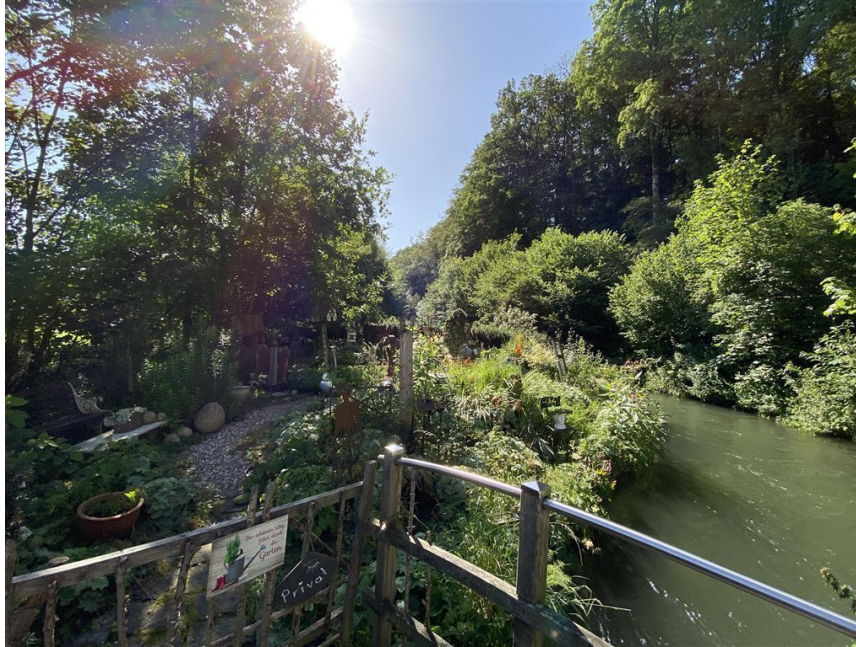
Wehr mit Fischtreppe
